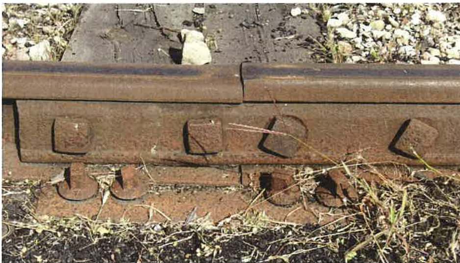
Zdjęcie nr 8. Nierówności pionowe na styku wynikające z zastosowania różnych typów szyn.
