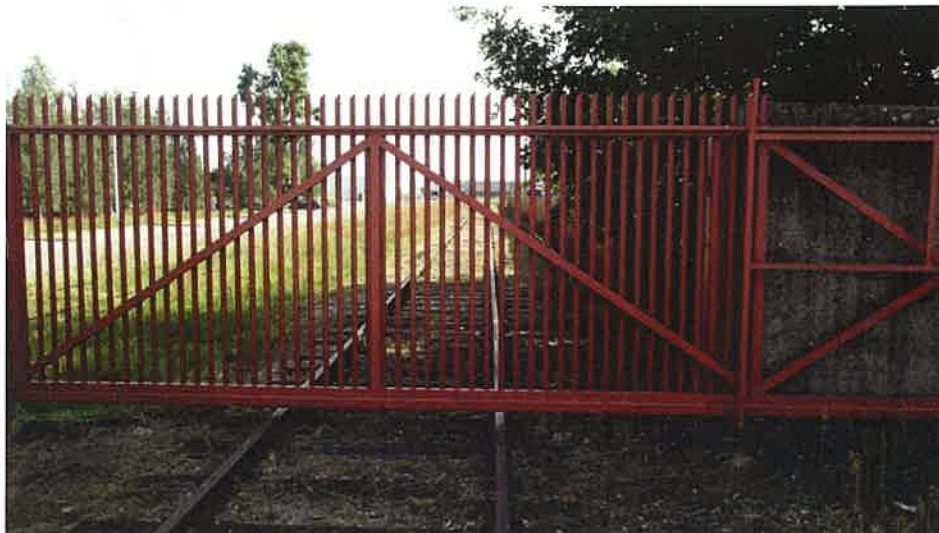
Zdjęcie nr 5. Brak tarcz D 1 po obu stronach bramy wyjazdowej oraz drzewa w skrajni toru.
