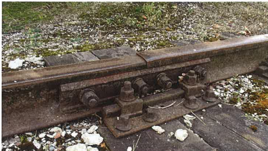
Zdjęcie nr 9. Nierówności pionowe na styku wynikające z zastosowania różnych typów szyn.
