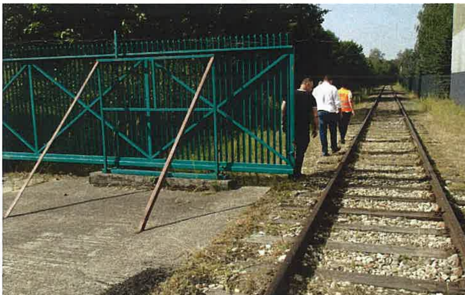
Zdjęcie nr 6. Brak tarcz D1 po obu stronach bramy wjazdowej.
