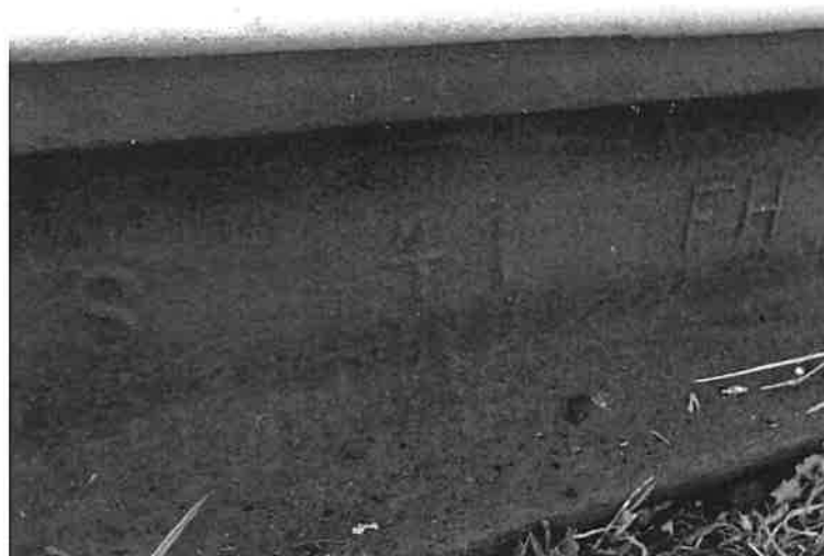
Zdjęcie nr 3. Szyna S41 zabudowana na boczniczy PEC w Ełku.
