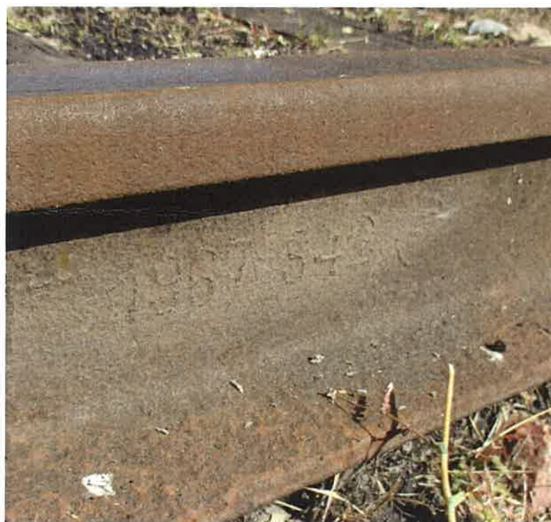
Zdjęcie nr 2. Szyna S42 zabudowana na boczniczy PEC w Ełku.
