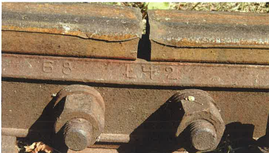
Zdjęcie nr 10. Spływy boczne szyny na stykach.
