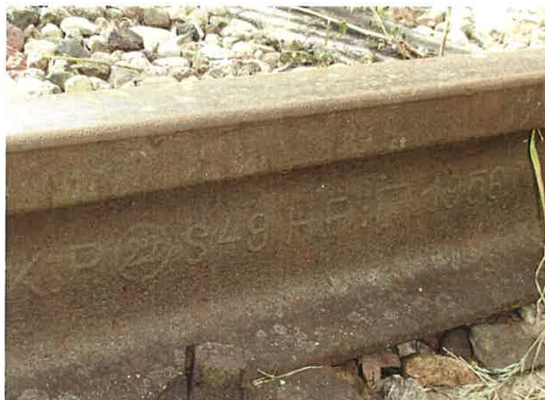
Zdjęcie nr 1. Szyna S49 zabudowana na boczniczy PEC w Ełku.
